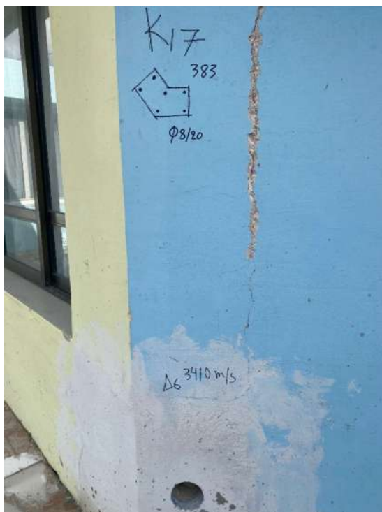
Θέση δοκιμίου 6 – Υποστύλωμα K17
