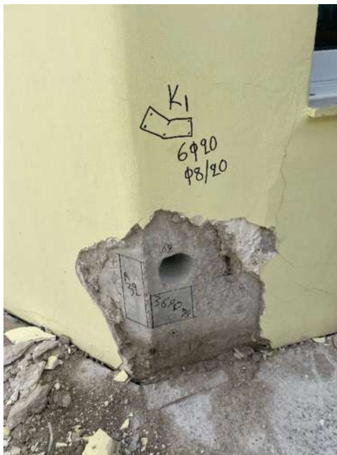
Θέση δοκιμίου 2 – Υποστύλωμα K1
