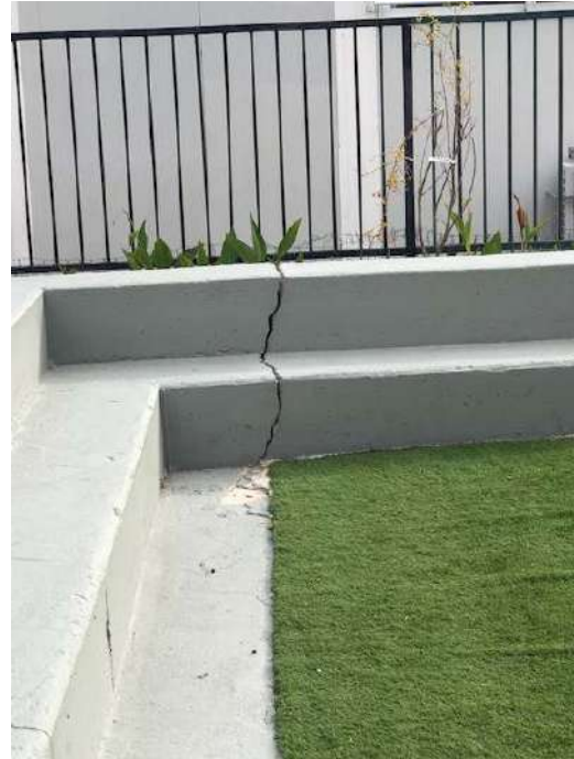
Εικόνα 8. Ρηγματώσεις πλάκας διαμόρφωσης περιβάλλοντος χώρου
