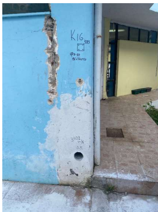
Θέση δοκιμίου 5 – Υποστύλωμα K16
