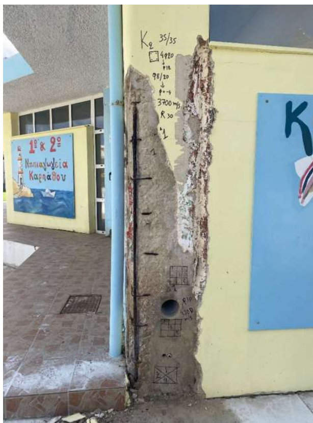
Θέση δοκιμίου 1 – Υποστήλωμα K2
