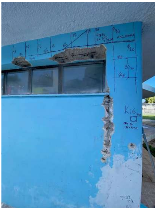
Υποστύλωμα K16 και οπλισμός δοκού.
