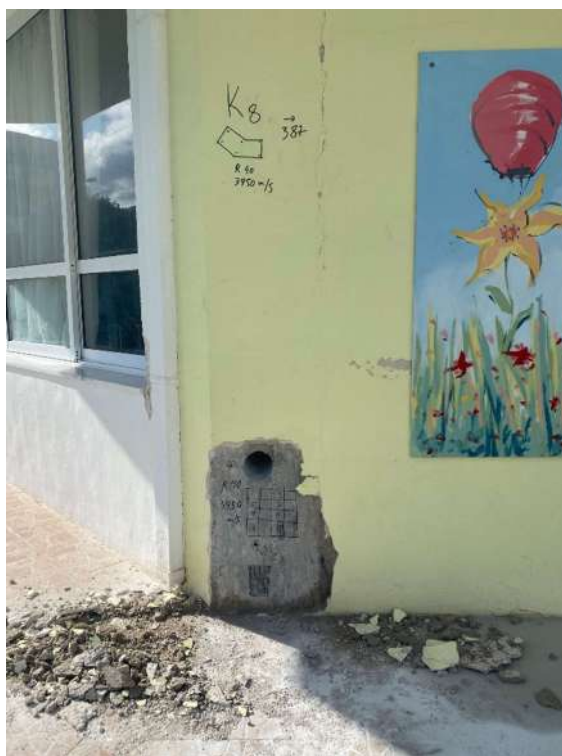
Θέση δοκιμίου 3 – Υποστύλωμα K8
