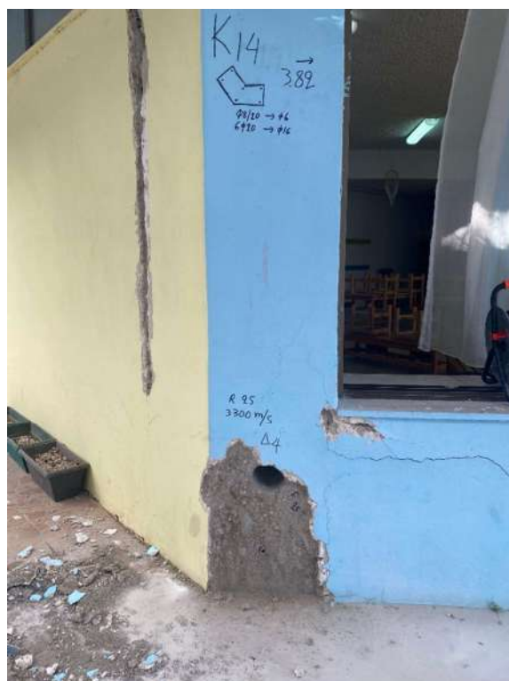
Θέση δοκιμίου 4 – Υποστύλωμα K14
