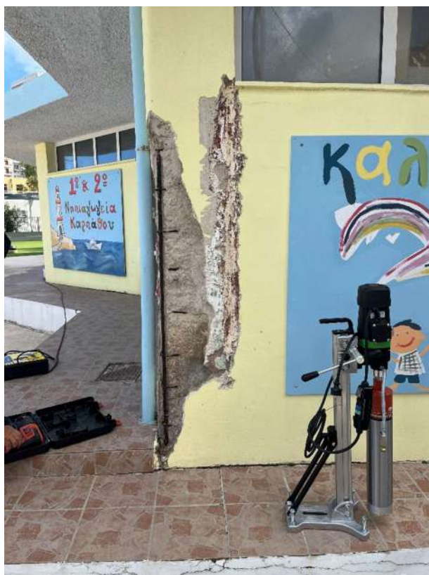
Προετοιμασία για την λήψη δοκιμών σκυροδέματος.
