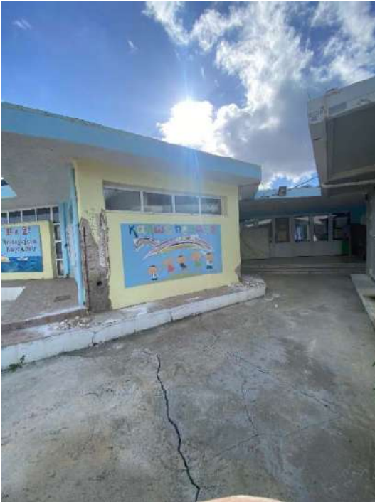
Εικόνα 8. Ρηγματώσεις πλάκας διαμόρφωσης περιβάλλοντος χώρου
