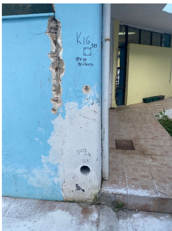
Θέση δοκιμίου 5 – Υποστύλωμα K16
