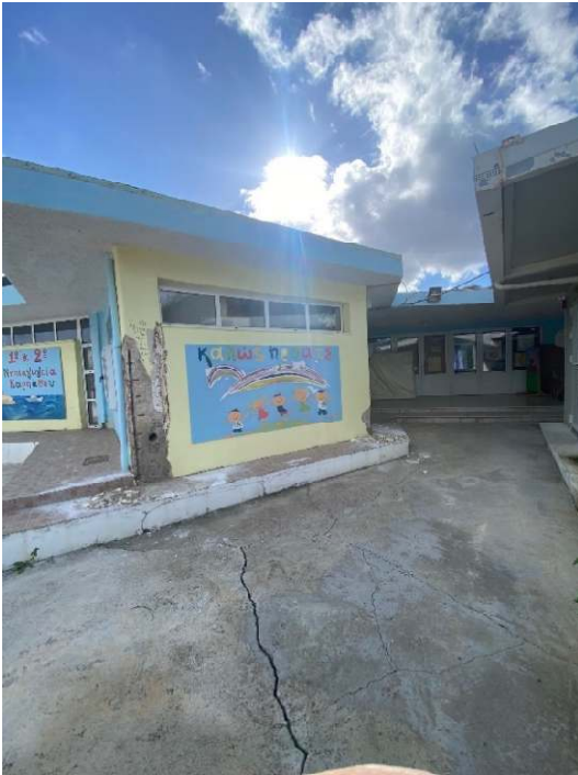
Εικόνα 8. Ρηγματώσεις πλάκας διαμόρφωσης περιβάλλοντος χώρου
