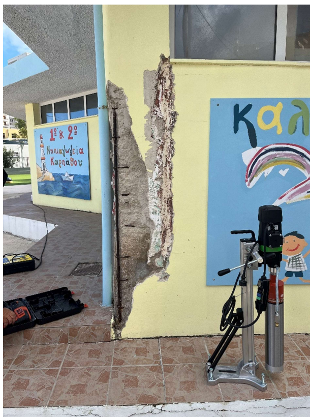
Προετοιμασία για την λήψη δοκιμών σκυροδέματος.
