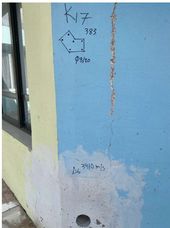
Θέση δοκιμίου 6 – Υποστύλωμα K17
