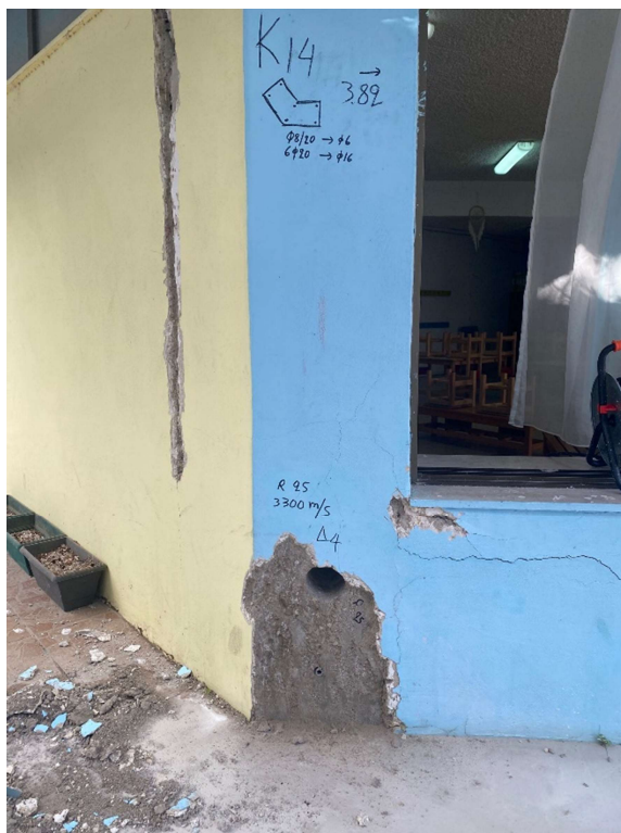
Θέση δοκιμίου 4 – Υποστύλωμα K14
