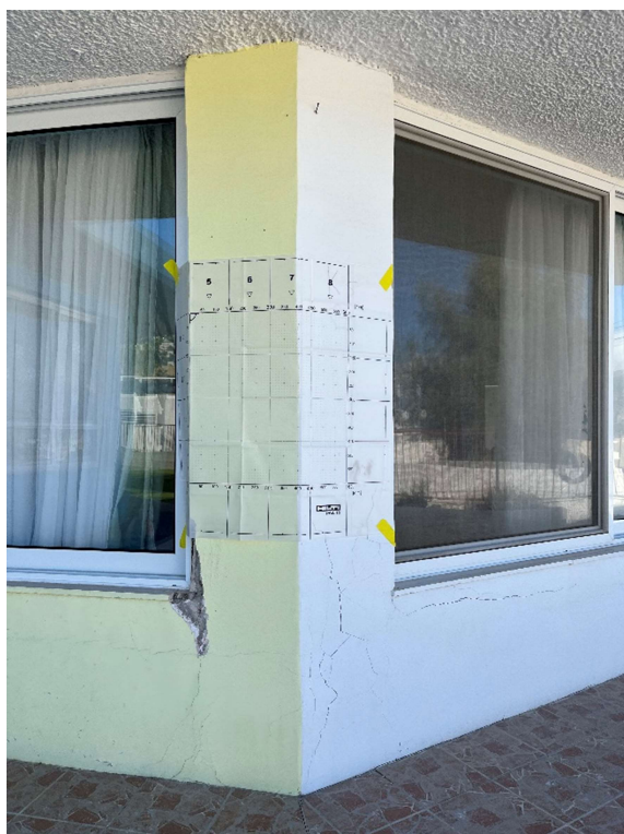
Μέτρηση κανάβου Υποστυλώματος K5 με Hilti PS300 & PS1000.
