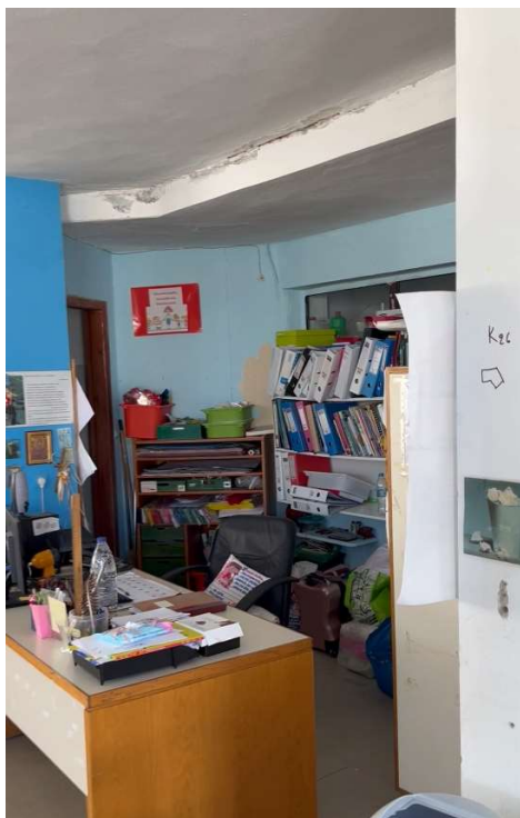
Υποστύλωμα K26 & K27
