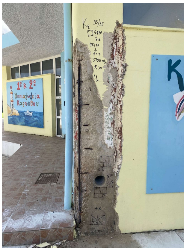
Θέση δοκιμίου 1 – Υποστήλωμα K2
