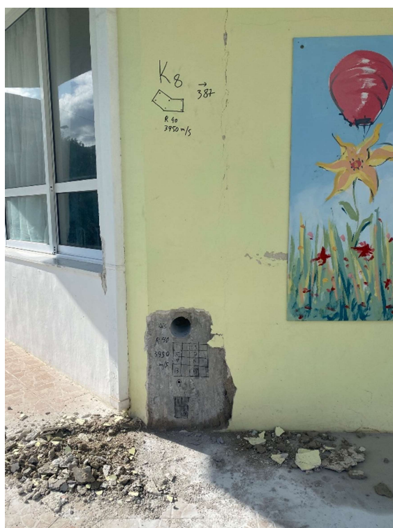
Θέση δοκιμίου 3 – Υποστύλωμα K8
