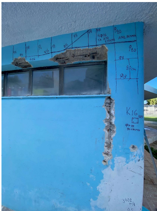
Υποστώλωμα Κ16 και οπλισμός δοκού.
