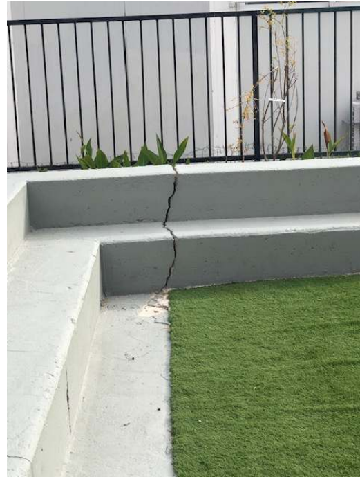
Εικόνα 8. Ρηγματώσεις πλάκας διαμόρφωσης περιβάλλοντος χώρου
