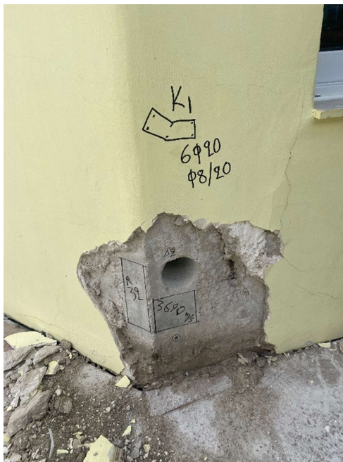
Θέση δοκιμίου 2 – Υποστύλωμα K1
